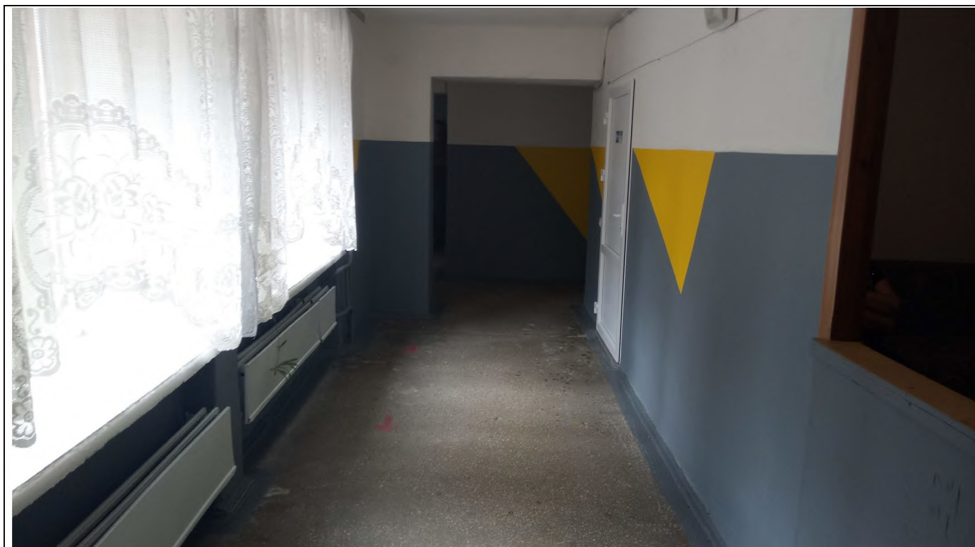
Фото №5. Коридор на першому поверсі будівлі
