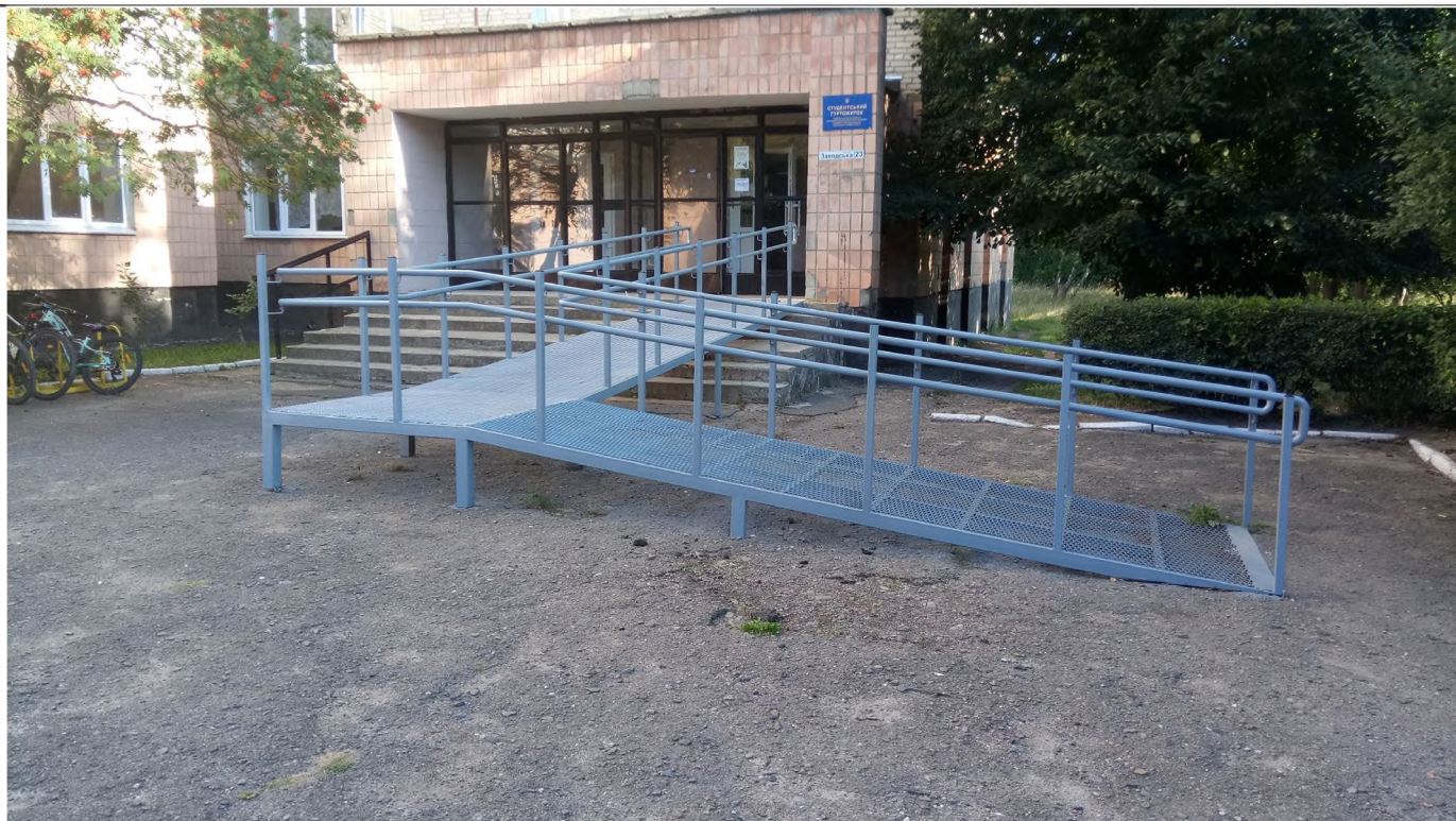
Фото №3. Пандус на сходах перед входом в будівлю (другі сходи)
