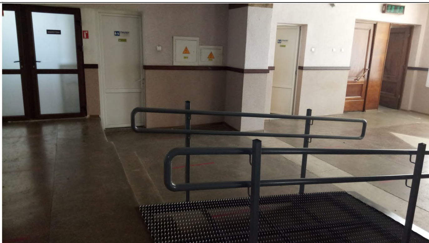
Фото №5. Пандус та санвузли на першому поверсі будівлі
