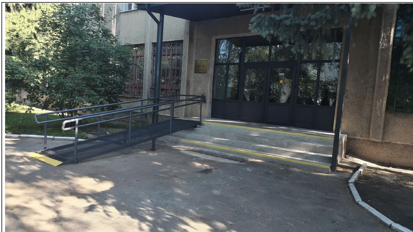
Фото №3. Вхідна група будівлі
