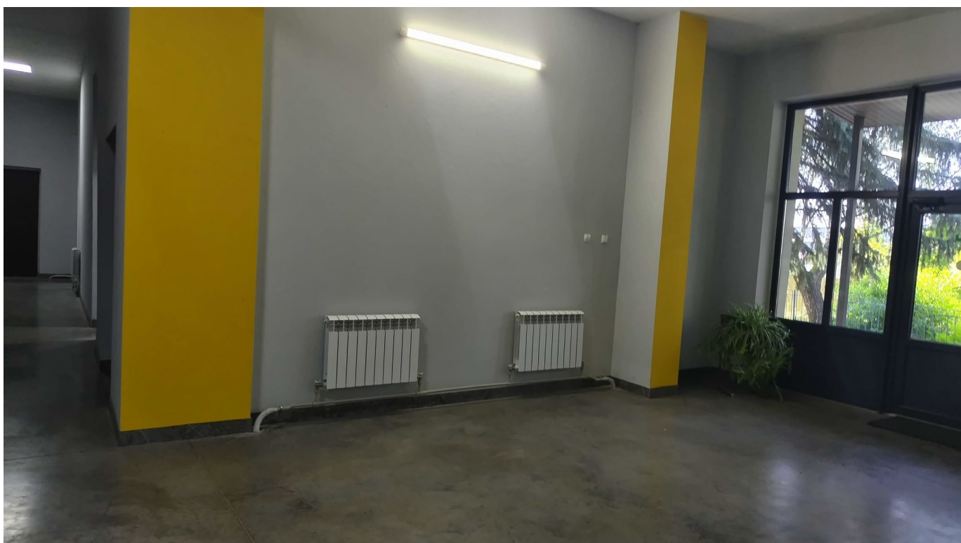
Фото №8. Стан приміщень будівлі
