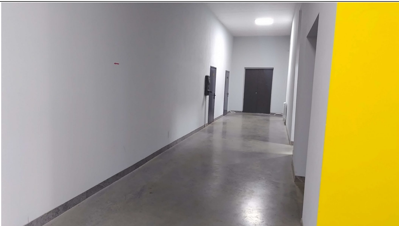
Фото №7. Стан приміщень будівлі
